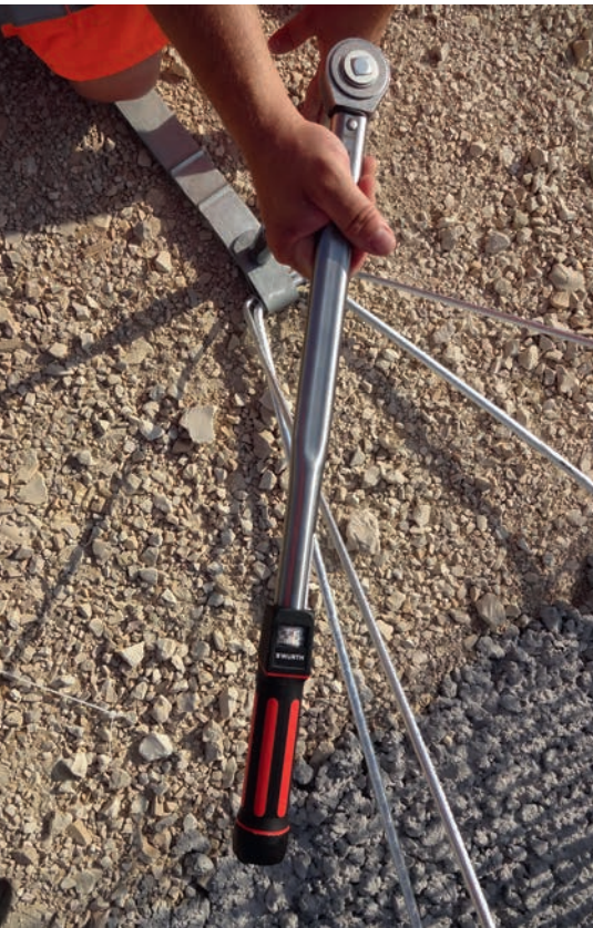
Abb. 5: Verschrauben des Bewehrungsbandes mit dem Stahlgitterelement
