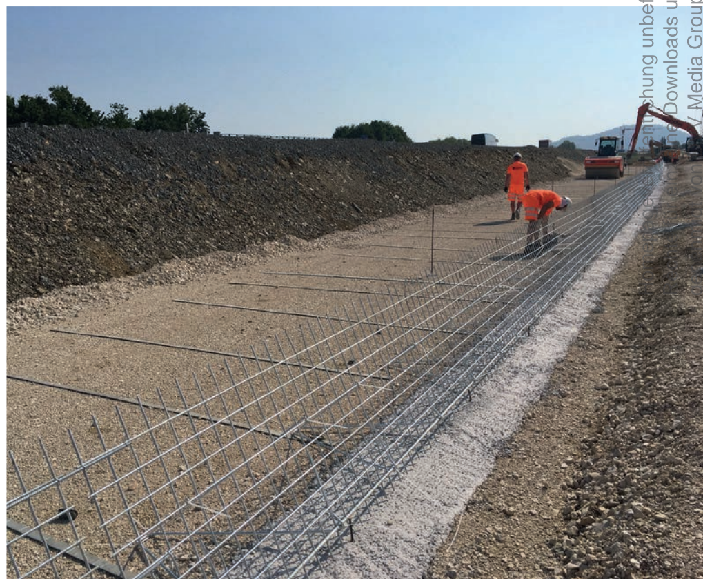
Abb. 4: Einbau des Füllbodens und der Bewehrungsbänder
