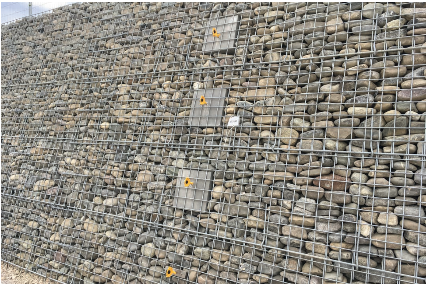
Abb. 6: Anordnung der Verformungsmesspunkte
